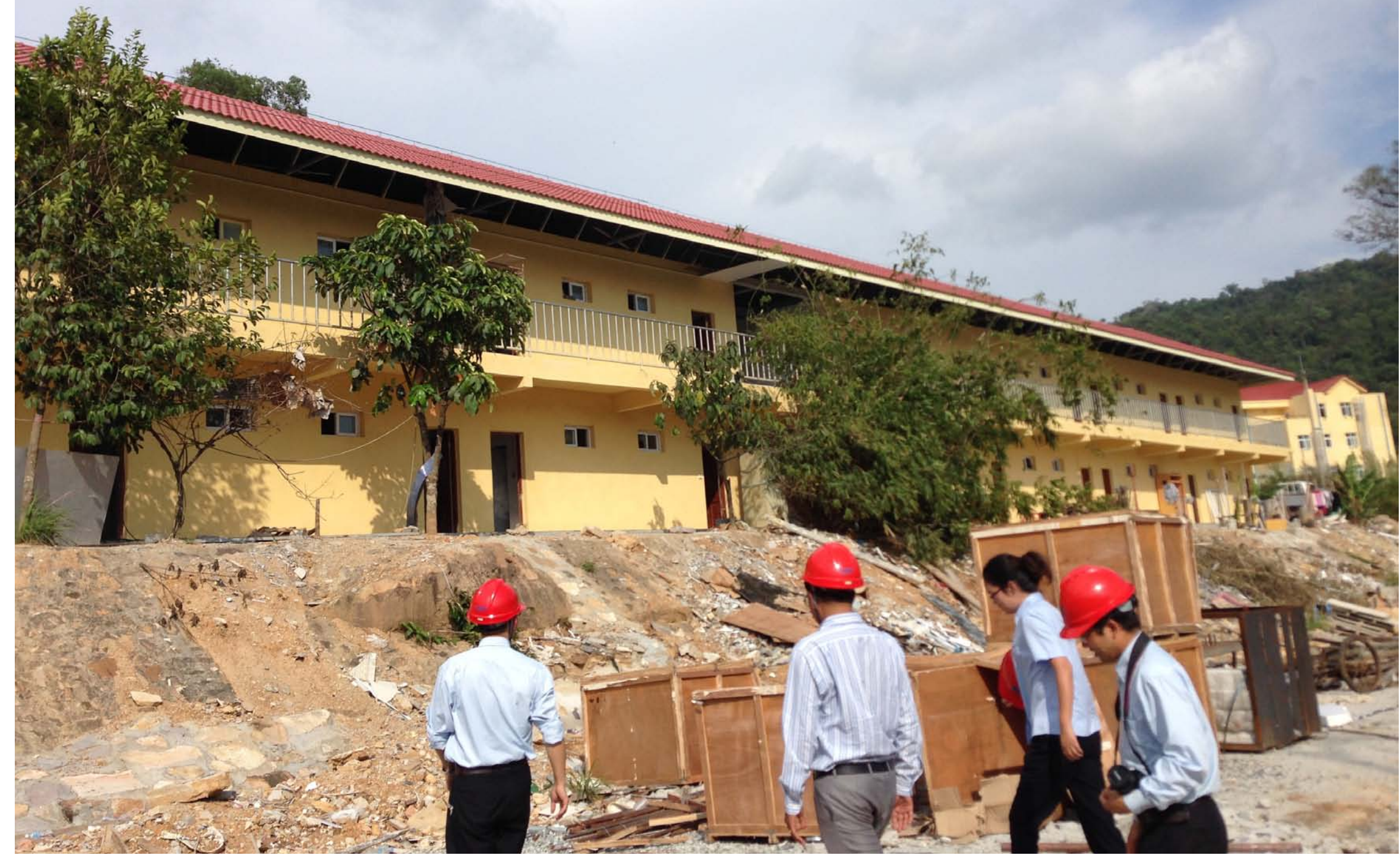
柬埔寨额勒赛水电站为柬埔寨员工新建的宿舍楼
